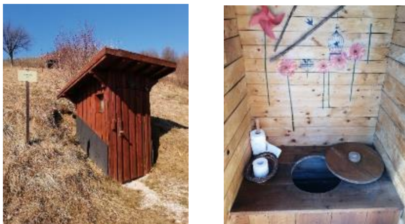
Slika 21: Kompostno stranišče s podzemnim sistemom cevi, ki vodijo kompost do obdelovalnih površin 31
