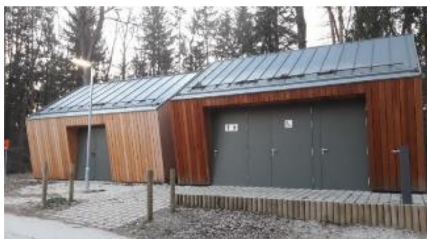
Slika 18: Sanitarni objekt ob Šmartinskem jezeru 28
