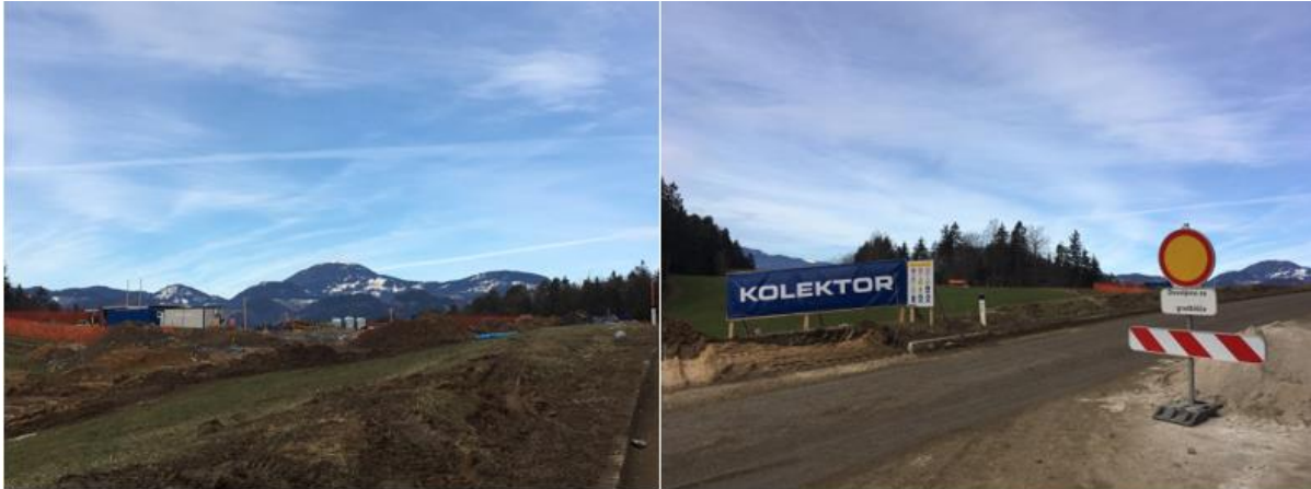
Slika 14: Začetek gradbenih del v Gaberkah, 30. 1. 2021 14
