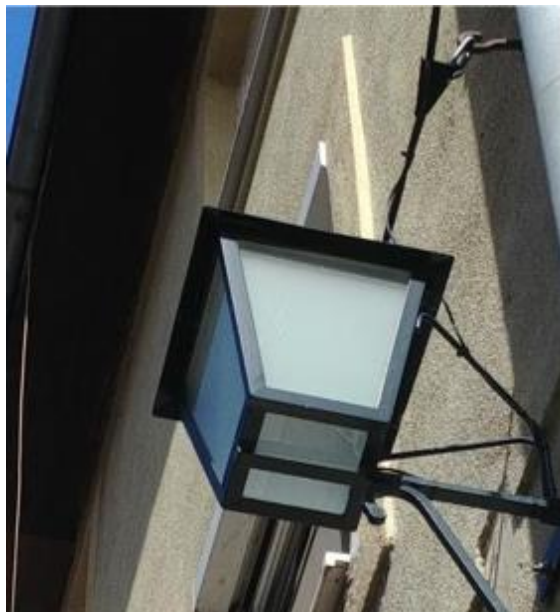
Slika 59 – LED historična svetilka montirana na fasado [4]
