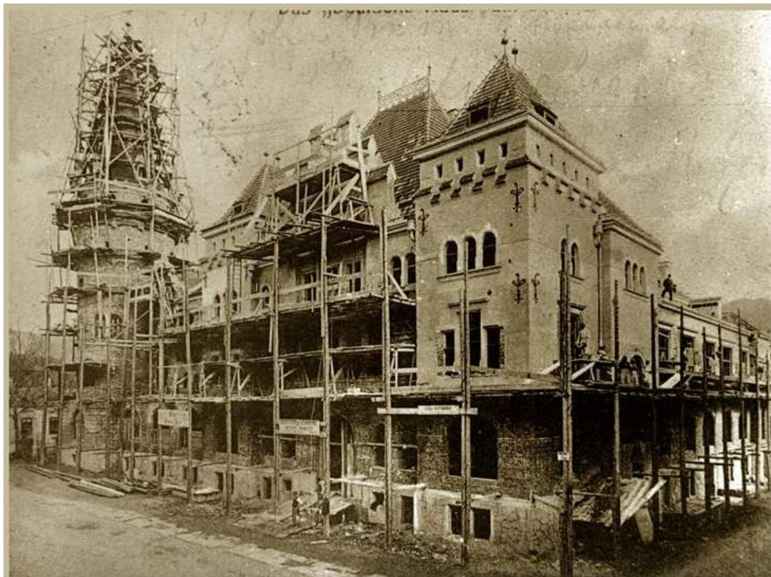
Slika 36: Gradnja Nemške hiše (Vir: www.kamra.si , 7. 3. 2016)
