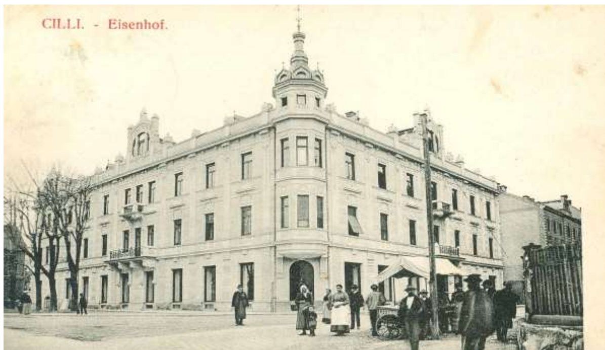
Slika 27: Železni dvor pred 1. svetovno vojno (Vir: ZAC)
