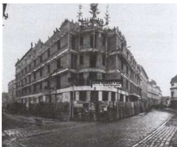
Slika 38: Posojilnica v gradnji, na strehi so zbrani delavci, spodaj je napisna tabla podjetja Gologranca. (Vir: ZAC)
