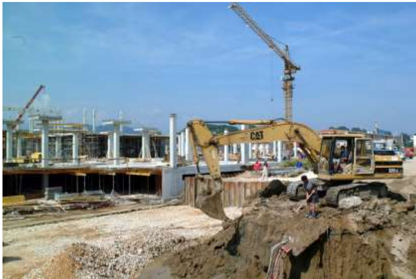
Slika 48: Gradnja centra Planet Tuš (Vir: MNZC)
