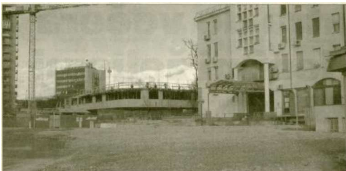
Slika 26: Mesto, kjer je stal kino Dom. V ozadju vidimo objekt Maksimilijan v gradnji. (Vir: Novi tednik , 18. december 2003)
