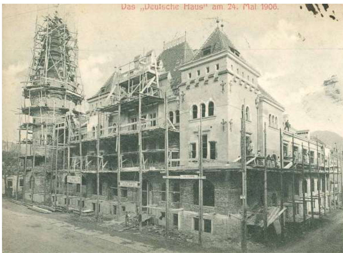
Slika 33: Gradnja Nemške hiše na stari razglednici (Vir: ZAC)
